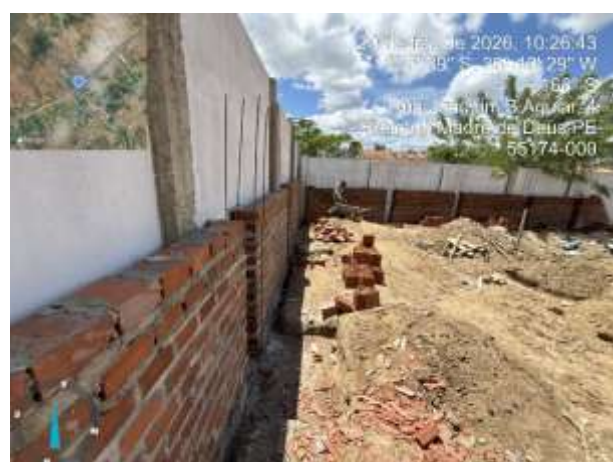
FOTO 05: ALVENARIA DE EMBASAMENTO;
