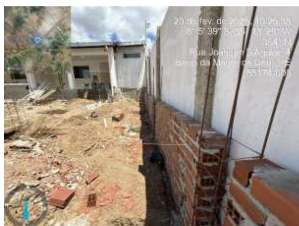
FOTO 06: ALVENARIA DE EMBASAMENTO;
