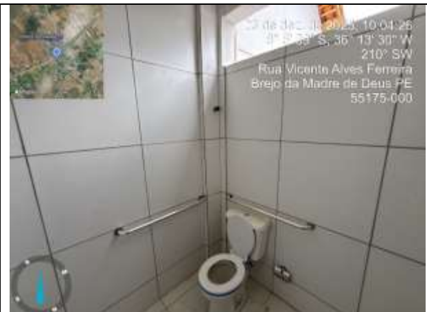
FOTO 08: BARRA DE APOIO INSTALADA;
