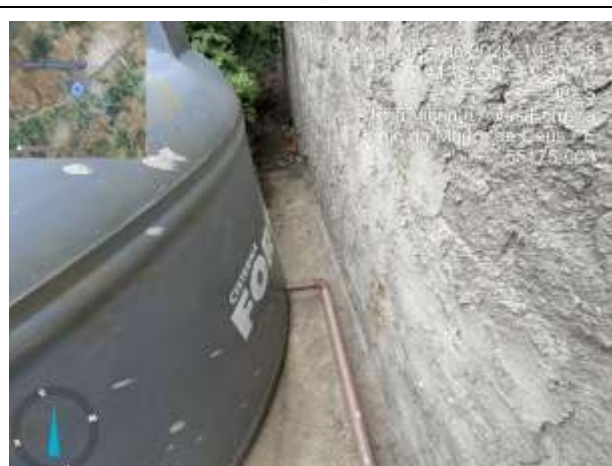
FOTO 04: INSTALAÇÃO DA CAIXA D'ÁGUA;
