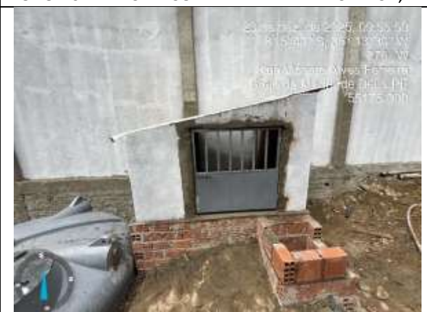
FOTO 12: PORTA DE FERRO INSTALADA;
