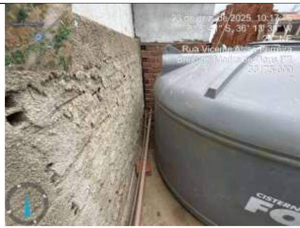
FOTO 03: INSTALAÇÃO DA CAIXA D'ÁGUA;
