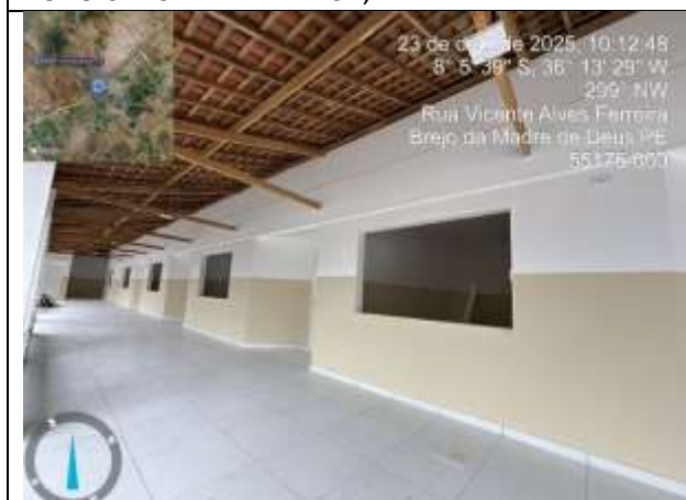
FOTO 09: PINTURA COM TINTA LÁTEX ACRÍLICA;
