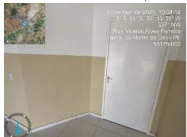
FOTO 10: PINTURA COM TINTA LÁTEX ACRÍLICA;
