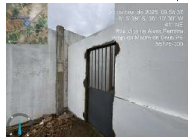
FOTO 11: PORTA DE FERRO INSTALADA;
